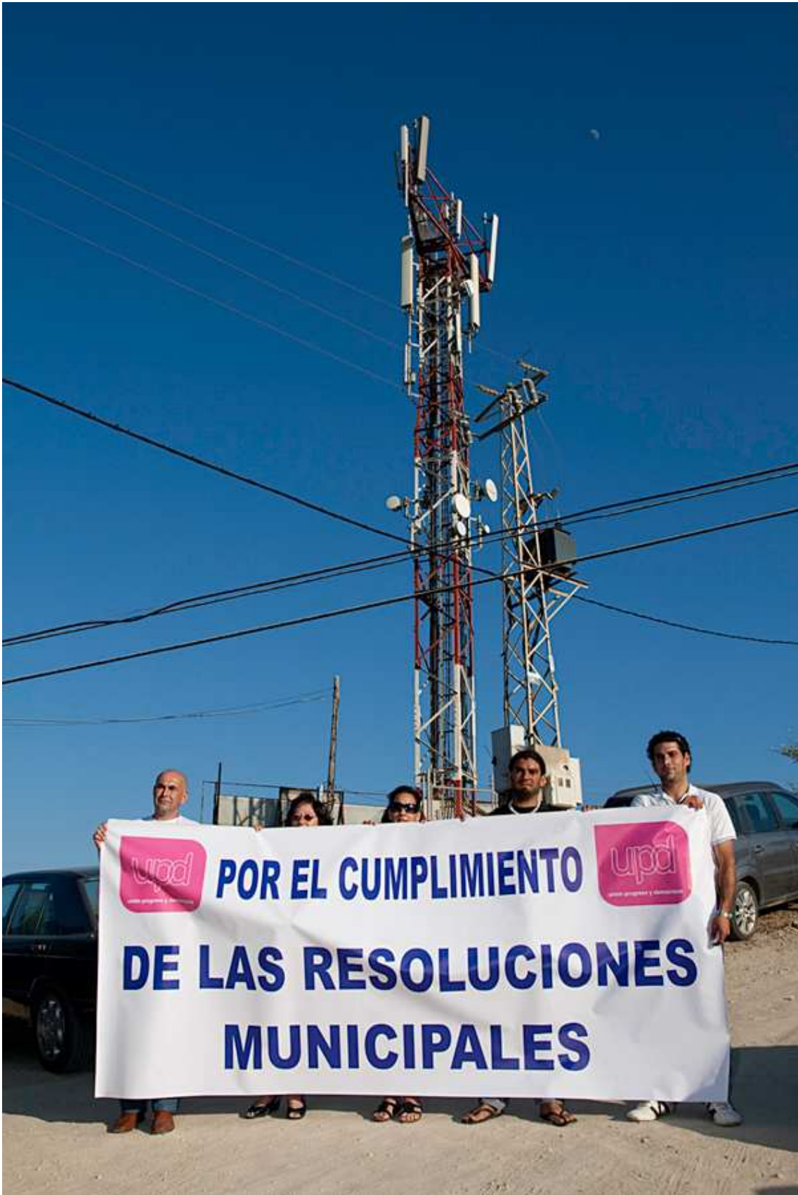
Llegando a la Antena de la discordia construida ilegalmente desde hace mas de 15 años
