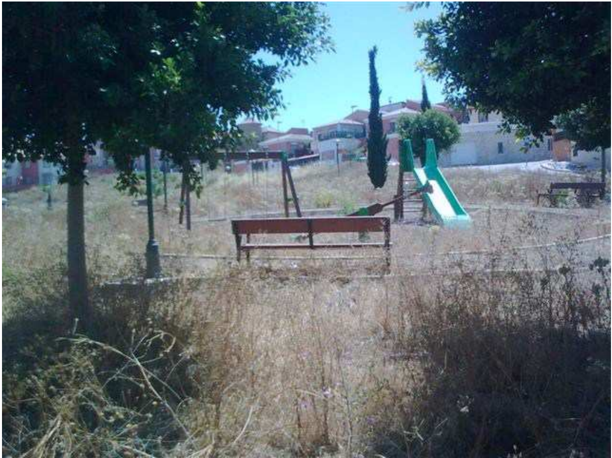
Estado de conservación del Parque Infantil de Benajárfes
